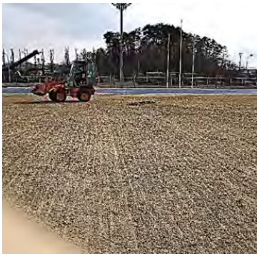
写真1 大型鉄製レイキをトラックターでけん引している不陸整正状況、遠景 ＜インフィールドクレイグラウンド＞
