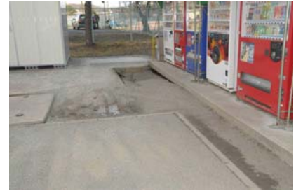
<自動販売機前の陥没>
