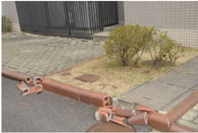
<タイルの破損・うねり>
